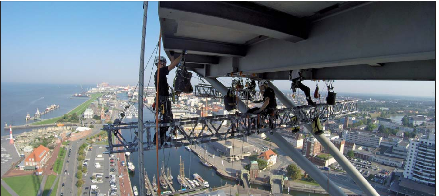
Korrosionsschutzarbeiten am Atlantic Hotel in Bremerhaven
