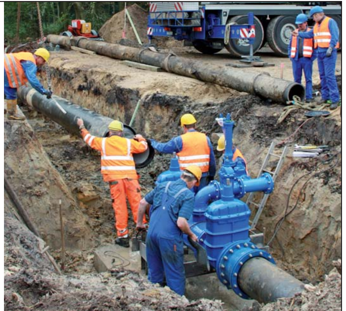
Einbindung einer Wasserleitung (Guss 400 mm)
