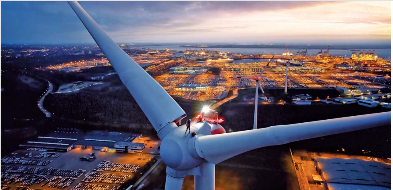
Atemberaubender Blick: Dieses Windrad hat eine Gesamthöhe von 206 Metern.
