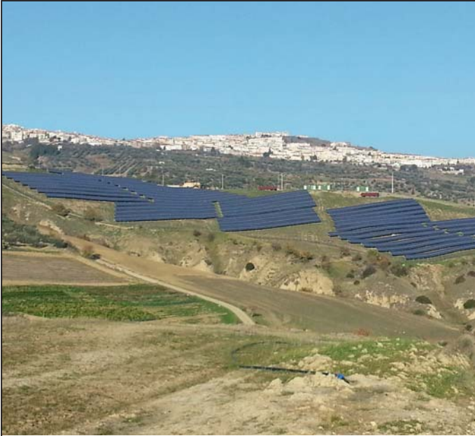
Das Solarkraftwerk Tempa unterhalb der Stadt Grassano, Provinz Matera, Italien
