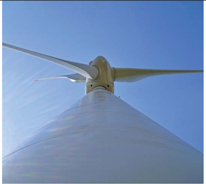
Eine Windenergieanlage der Multi-Megawatt Klasse Multi Megawatt-Class Wind Energy Converter
