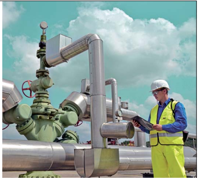
Mitarbeiter an einem Kavernenkopf Employee at a cavern well head
