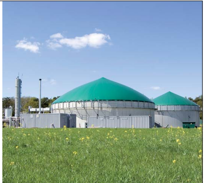
Landwirtschaftliche Biogasanlage mit vorgeschalteter Methanaufbereitungstechnik
